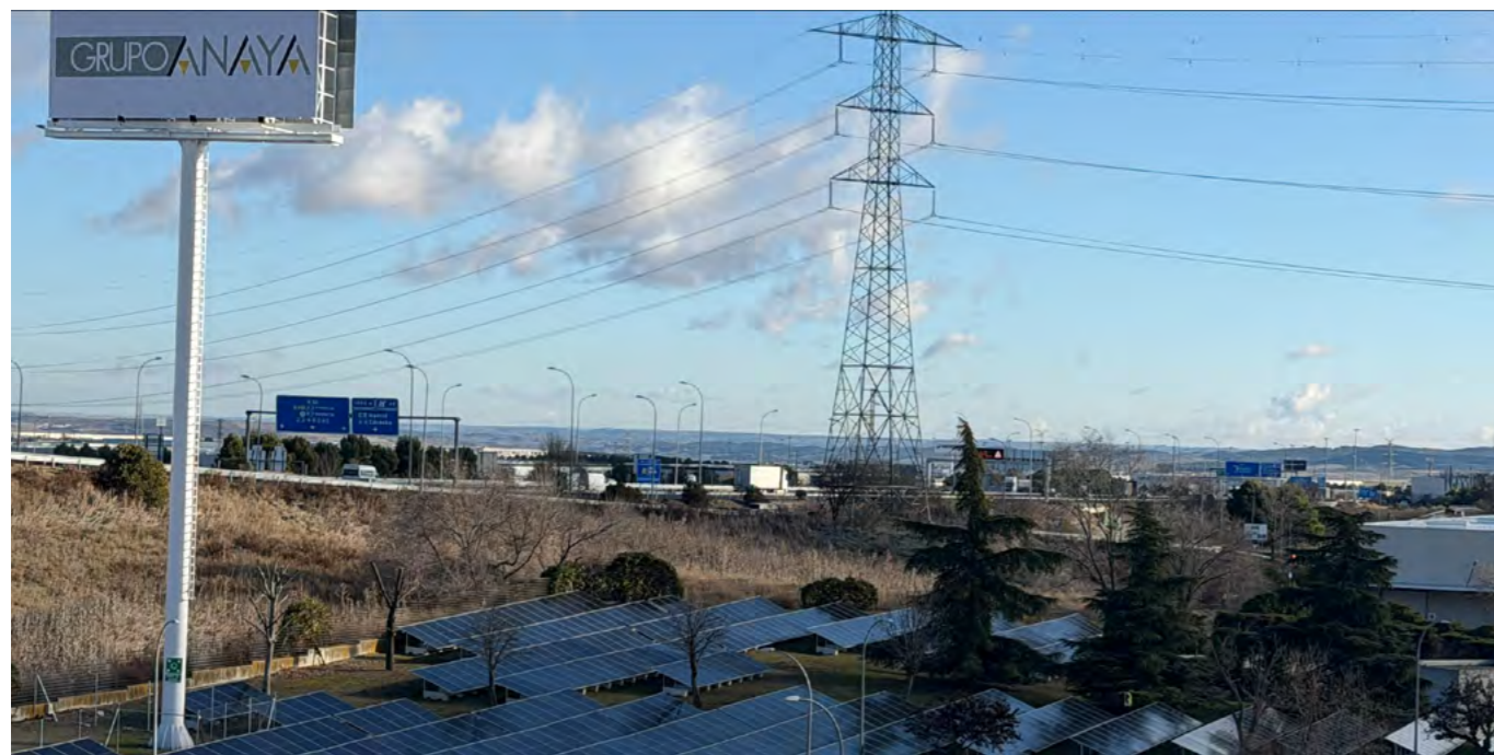
Installation de panneaux solaires sur le site logistique à Getafe en Espagne (Grupo Anaya).
